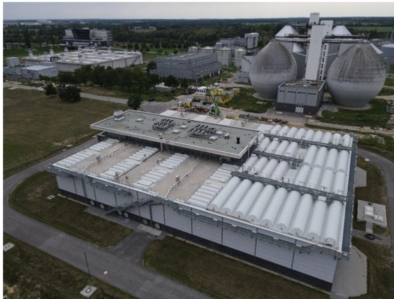
Abbildung 1: Luftaufnahme Prozesswasserbehandlung KW Waßmannsdorf
