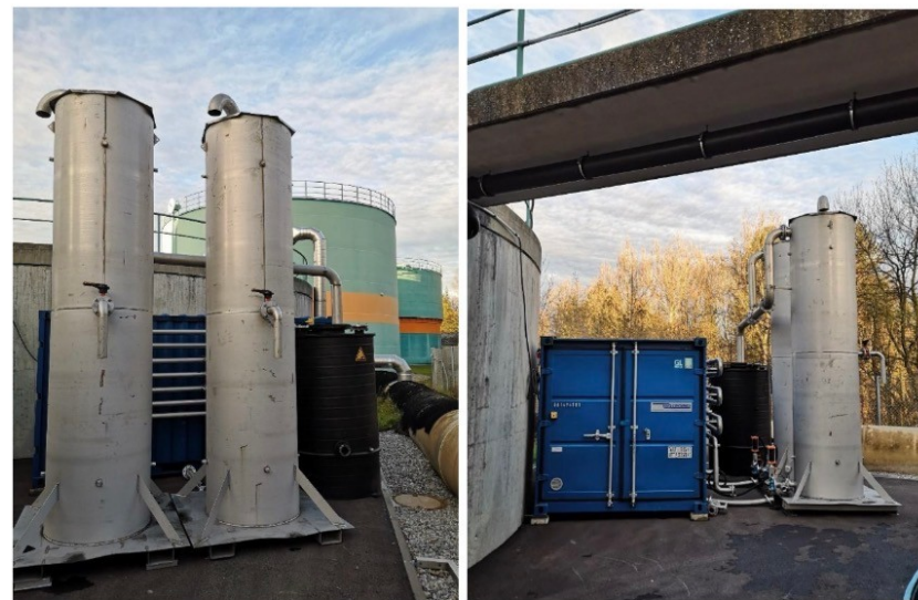
Aufbau in Kempten (460.000 EW) – blieb aber eine Zwischenstation (Teilstrom)...
