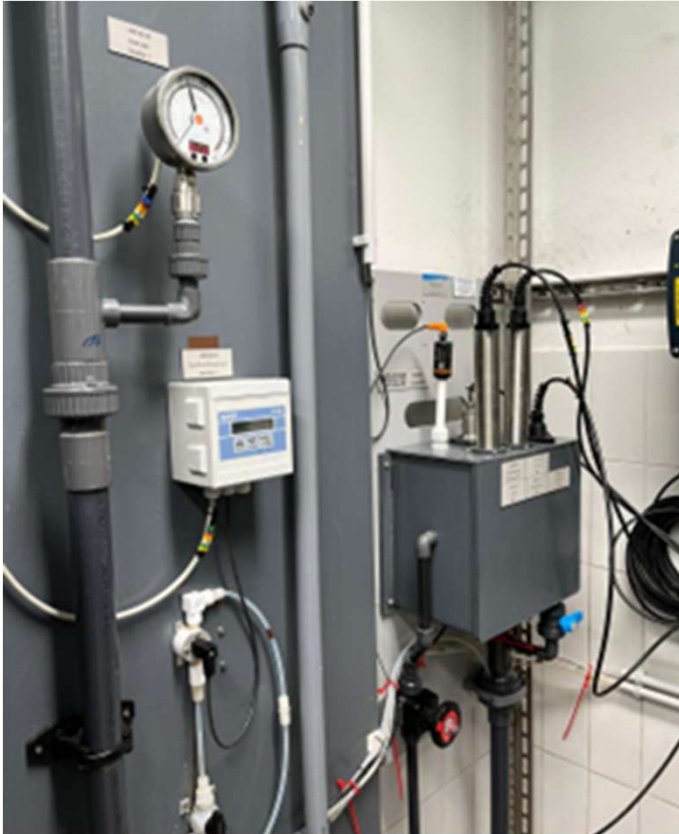
UF-Vorfiltration (Messung: \text{NH}_4\text{-N} , \text{NO}_3\text{-N} , \text{NO}_2\text{-N} )
