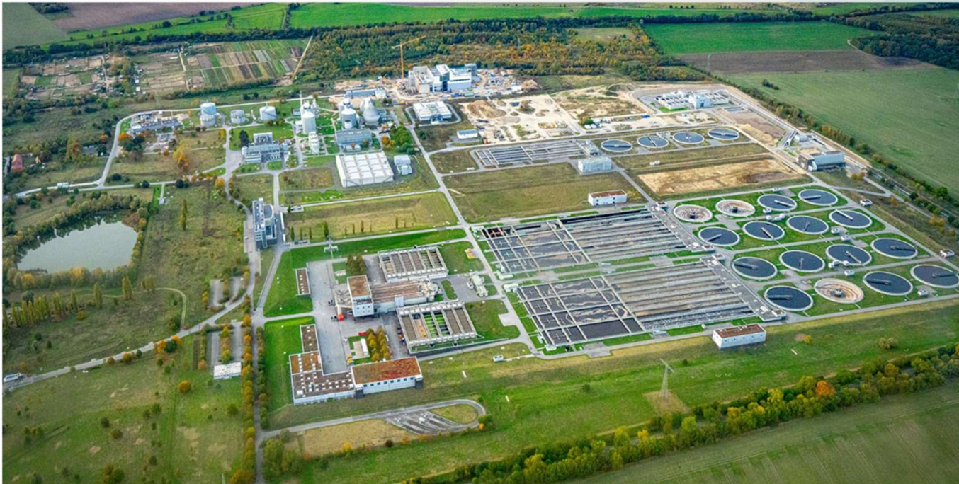
Luftbild Klärwerk Waßmannsdorf (Quelle: Berliner Wasserbetriebe)
