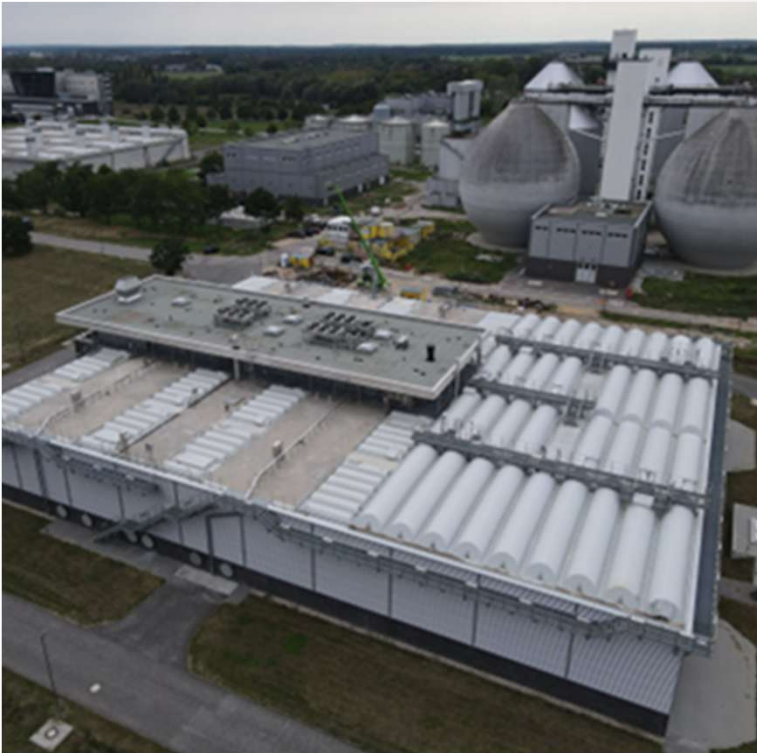
Luftaufnahme Prozesswasserbehandlung KW Waßmannsdorf (Quelle: Berliner Wasserbetriebe)
