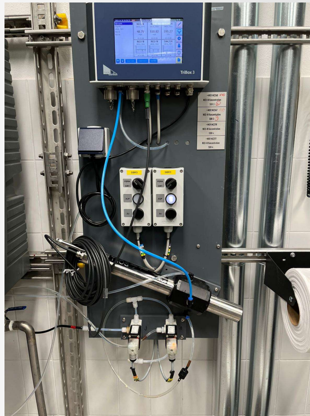
Spektralsonde (Messung: \text{NO}_3\text{-N} , \text{NO}_2\text{-N} )
