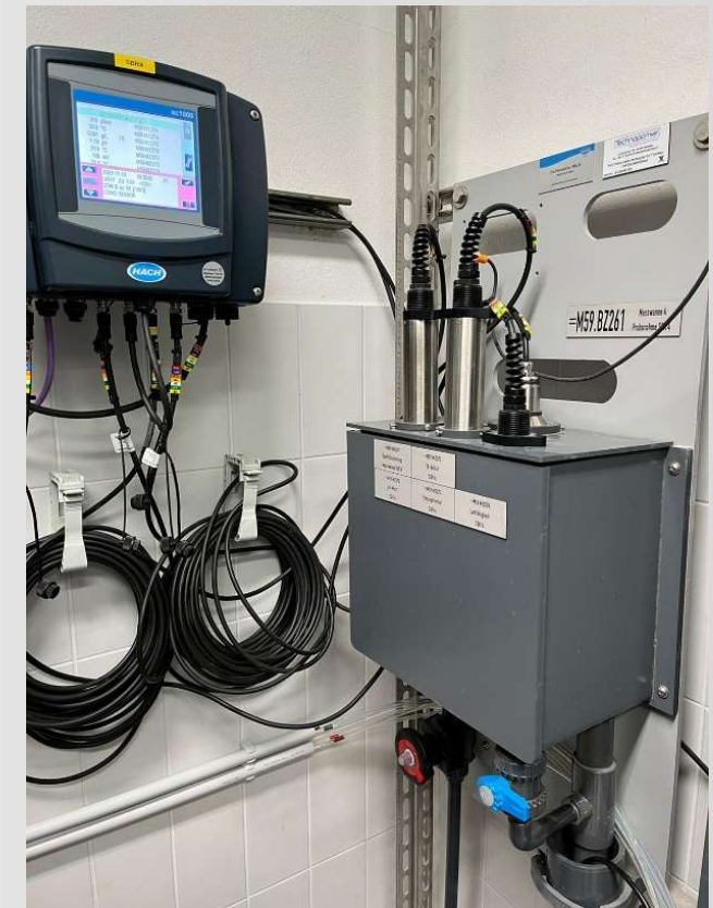
Messwanne: pH-Wert, Redoxspannung, TS-Gehalt, Leitfähigkeit
