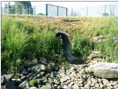
Verteilterrinne mit Wasserbausteinen
