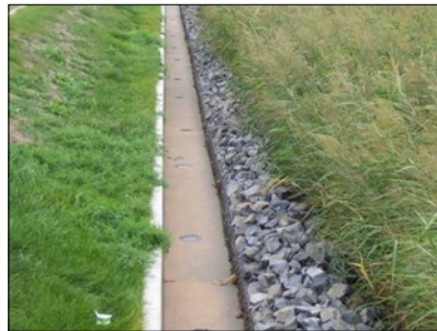
Verteilterrinne aus Beton mit Gabionen
