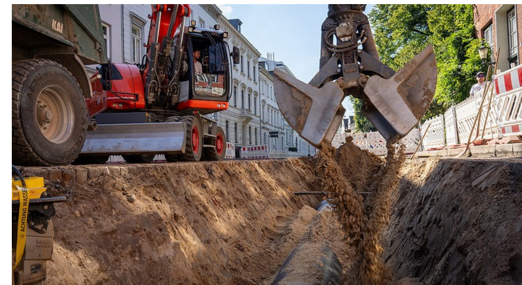
Foto: HamburgWasser von Elbchaussee Start zweiter Bauabschnitt - Hamburg Wasser
