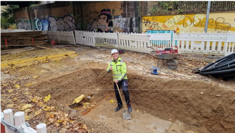
Foto: T. Banning, GEF Ingenieure Abwasserkolloquium Hafencity Universität Hamburg
